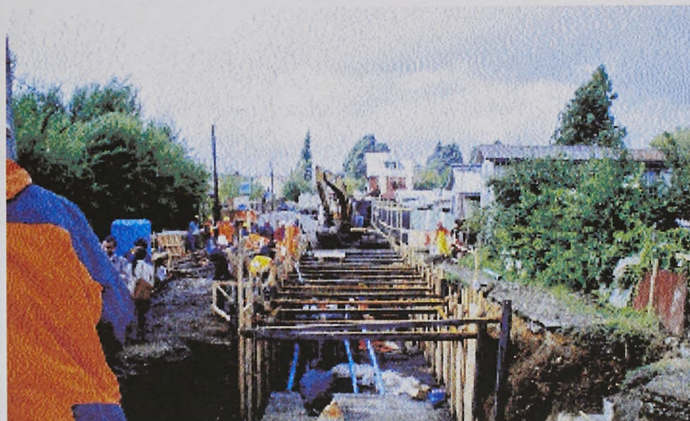
Construcción del colector de los barrios bajos de Valdivia.
